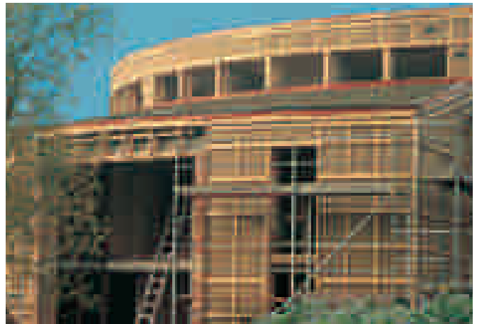
Tweegezinswoning: groen dak met 30 cm isolatie; muren in snelbouw met 16 cm isolatie + Celit 3D isolatiebeschermplaat
