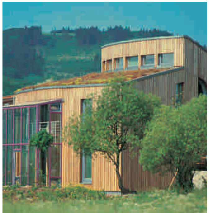
Tweegezinswoning: groen dak met 30 cm isolatie; muren in snelbouw met 16 cm isolatie + Celit 3D isolatiebeschermplaat
